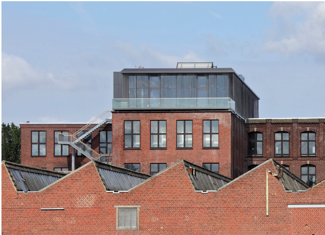
Blick von Osten auf Spinnerei Herding, im Vordergrund Sheddächer der Firma Ibena | © LWL-Industriemuseum
