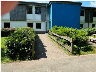
Verbindungswege zu den Häusern im Aussenbereich
