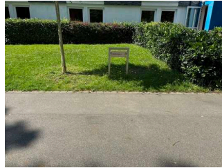
Verbindungswege zu den Häusern im Aussenbereich
